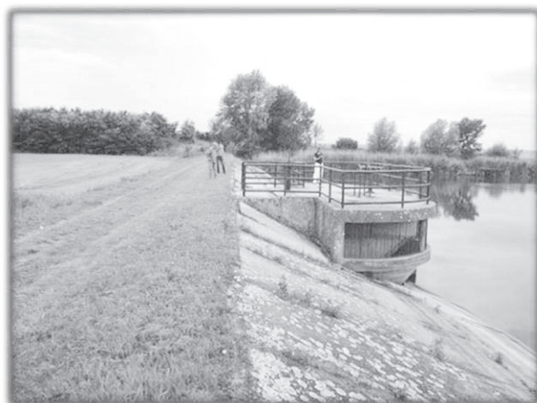
Imaginea 9 Clădirea pe acumulare Čonoplja, deversor
