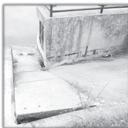
Imaginea 10: Clădirea pe acumulare Čonoplja, căptușeală de baraj
