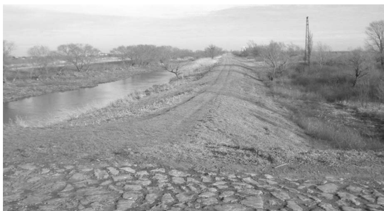
21. kép - A Bega-csatorna mentén lévő töltéskorona kinézete
